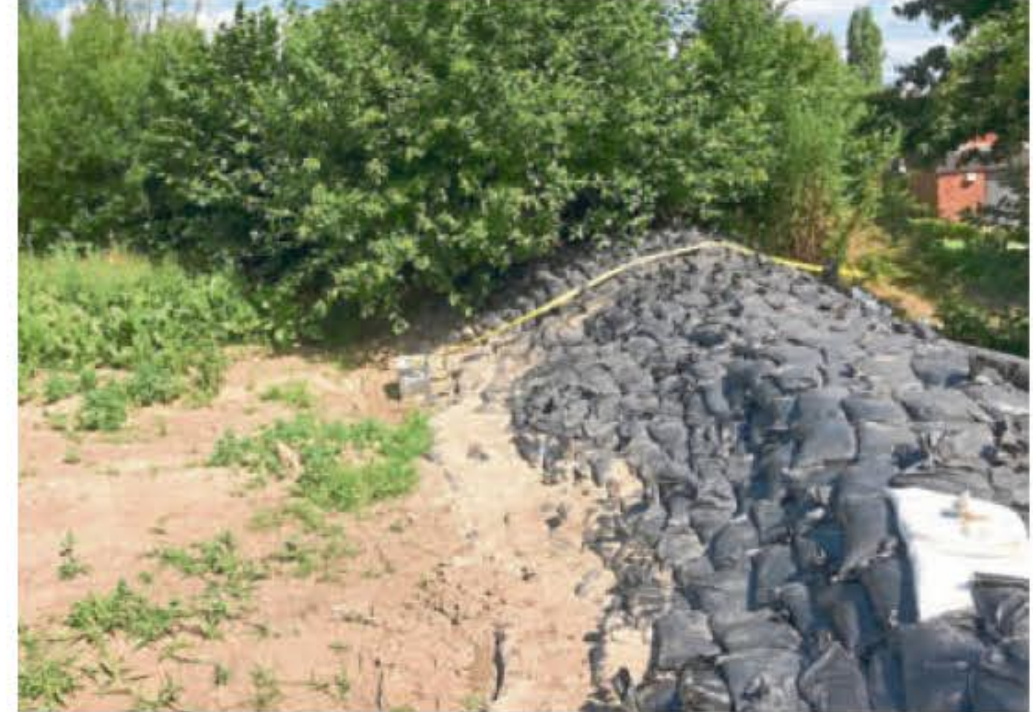
Hier, am tiefsten Punkt des Ackers, sammelt sich das Wasser. Vor- erst soll eine Pumpe (Mitte) einen Stau verhindern. Foto: Bexte
