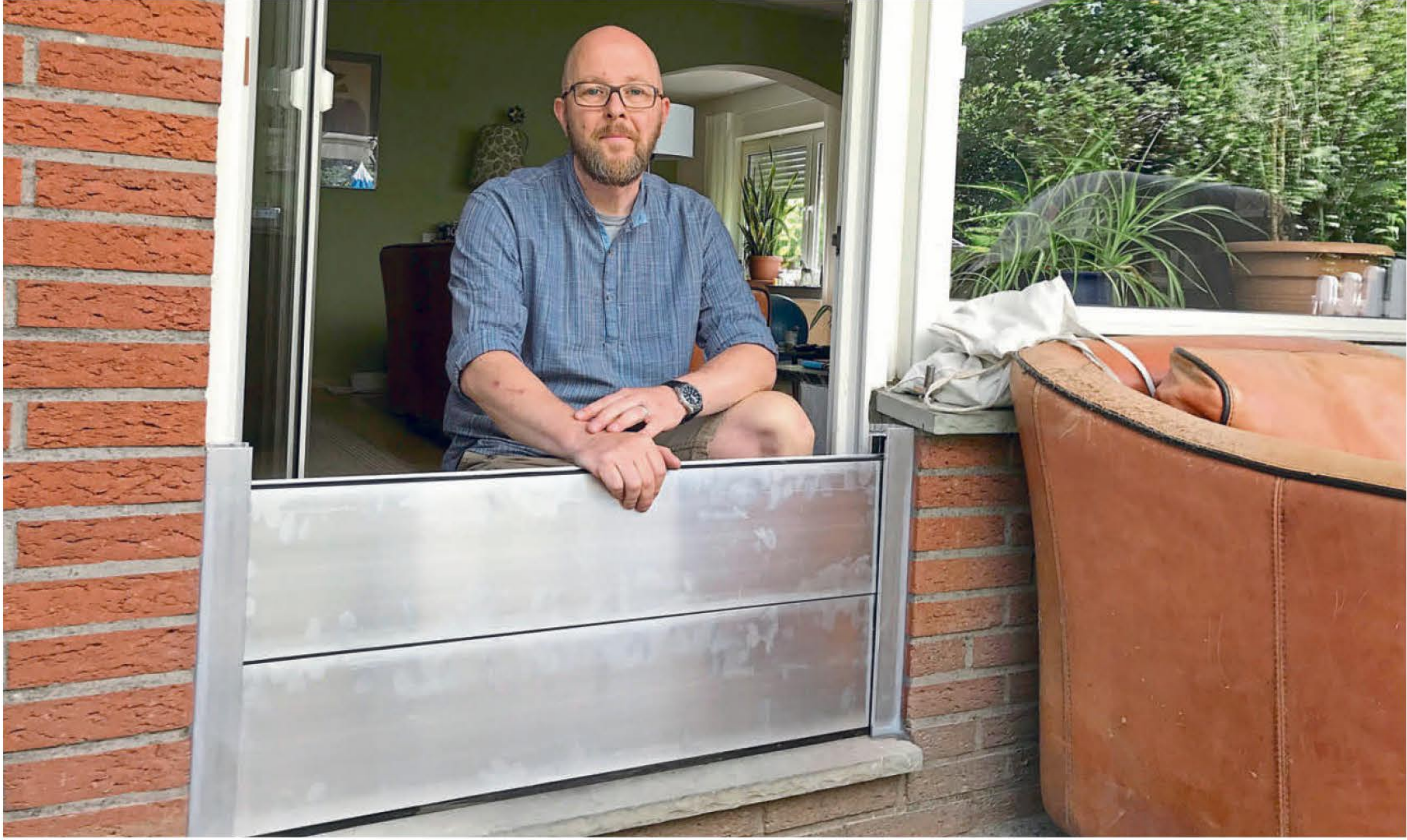
Stefan Jann (57) hat jetzt vor der Terrassentür eine Flutsperre aus Edelstahl montiert. Beim Starkregen im Mai fehlen nur knapp zwei Zentimeter, dann wäre das Wohnzimmer geflutet worden. Foto: Bexte
