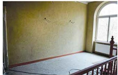
Das Treppenhaus im Obergeschoss hat jetzt schon den Wandanstrich, die Fußleisten haben den Voranstrich.
