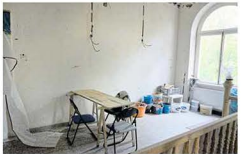
Zu Beginn der Bauarbeiten wurde das Treppenhaus im Obergeschoss von den Malern als Baubüro und Lagerfläche genutzt.
