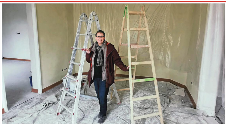
Sonja Langkafel in einem bereits fertig gestrichenen Raum: Bis Ende März soll die Sanierung der ersten Etage abgeschlossen sein. Dann beginnt das Team mit dem Aufbau der Ausstellung. Foto: Hartmut Horstmann
